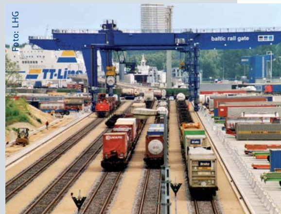
Mit dem KV-Terminal Baltic Rail Gate verfügt der Skandinavienkai über eine optimale Schienenanbindung an das Hinterland
