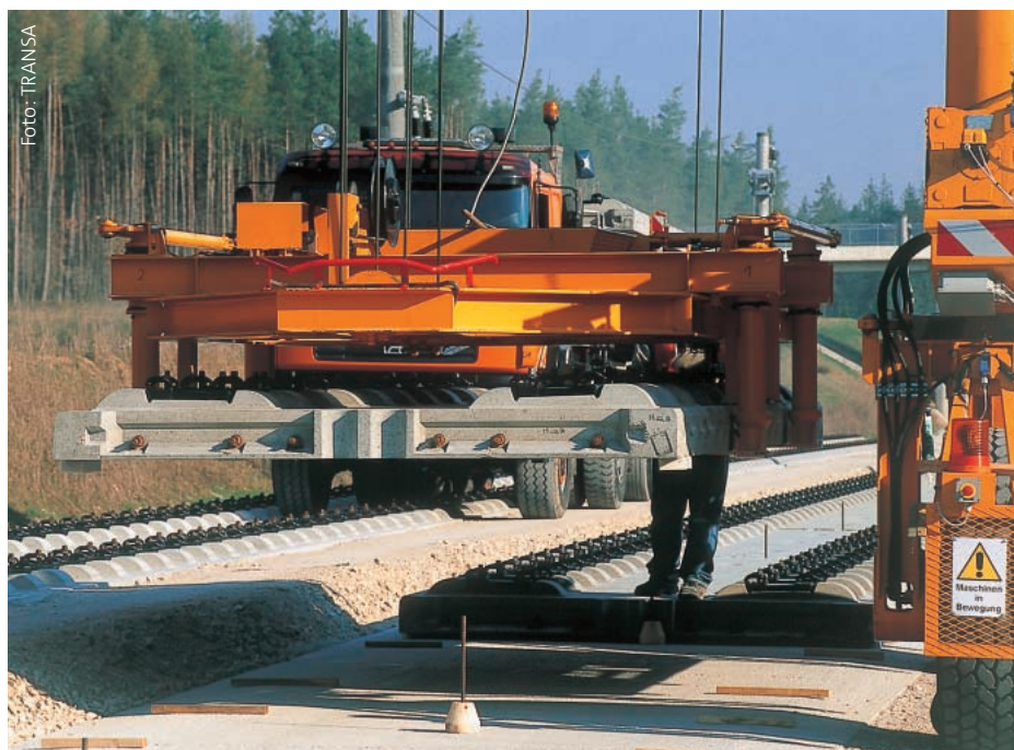
Der „Mobiler“, ein lasergesteuerter Hochkran, sorgt für den millimetergenauen Einbau der einzelnen Betonplatten
