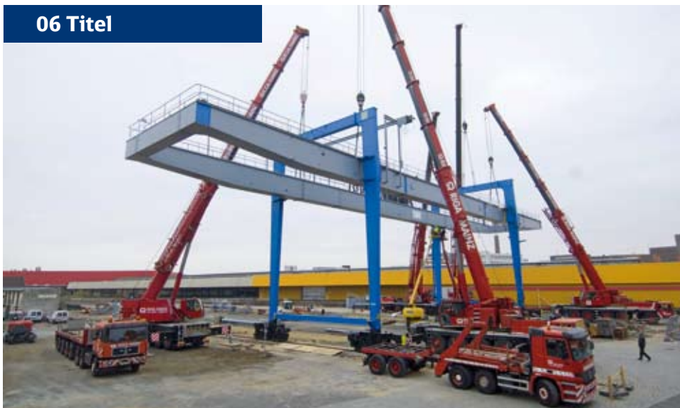
▲ Um die Abwicklung der logistischen Leistungen für die Donges Stahlbau GmbH zu optimieren, hat Railion eigens die Lagerkapazitäten seines Railports in Darmstadt erweitert und dort einen 42-Tonnen-Portalkran errichtet. Dadurch ist jetzt auch die Just-in-time-Zustellung von Stahlblechen in die Produktion des Stahlbauers möglich.
